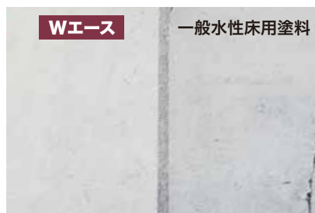
試験箇所: 当社構内、屋外コンクリート面
