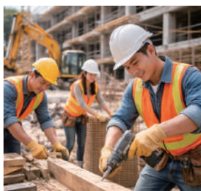
建築現場・作業場
