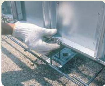
7. 吊巾止め金具を約900mm間隔にセットし、両サイドの爪をしっかり折り曲げます。
