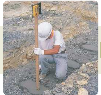
2. レベルが出ない場合には、砂または空練りモルタルでレベル調整します。
