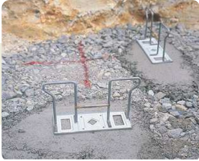
3. M型鉄筋ベースをコーナー部および直線部に設置します。(コーナー部455mm以内) (直線部1,365mm以内)
