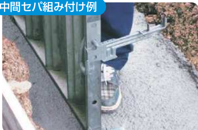
16. ハーフ吊中止金具を墨に合わせて、600mm以内に釘で固定します。次に、外周型枠を組み付けながらベタ中間セバを任意の高さに設置します。(コーナー部・500mm以内)(直線部1000mm以内)
