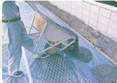
4. 外周基礎底面の高さを出すため、捨てコンクリートを打ちます。
