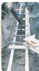
24. 次に立ち上がり部を打設します。
