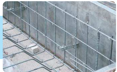
17. 立ち上がり筋とスラブ筋をセットします。
