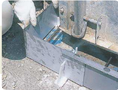
(鉄ベース枠2000・1125・625の各パネルは施工の長さに合わせ、組み合わせで使用します。) もう一方の外コーナーの端は100mmほど交差させるように鉄ベース枠をセットします。
