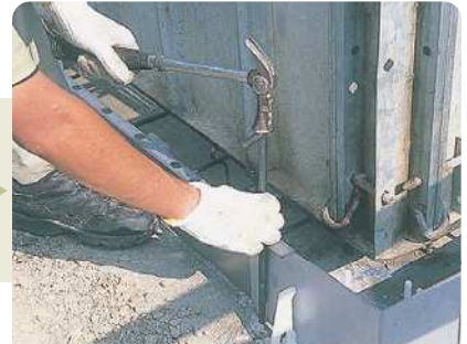
この時、コーナー両端に鉄ベース枠支持棒をクイ打ちします。
