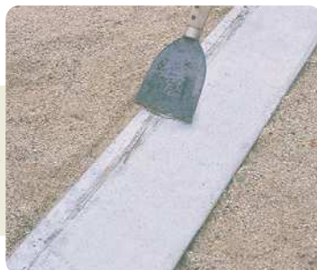
鉄ベース枠を取り外した際にケレンし、次回のためにNSPメタルフォーム油を塗っておきます。
