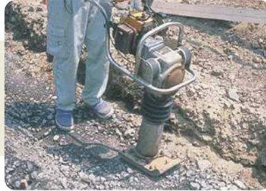
1. ベース部と土間部の砕石を転圧します
