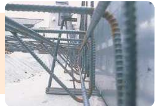
15. 段セバにセットされた外パネルと内パネル。▶ 20へ
