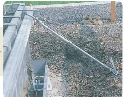
13. サポーターは300~500H用、600~750H用、800~950H用の中から施工に合わせて使い分けます。
