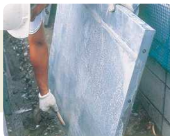
28. 外したパネルはケレンをし、次回のためにNSPメタルフォーム油を塗っておきます。
