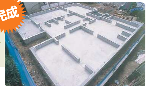
29. 脱枠し埋戻しをおこなえばベタ基礎の完成です。
