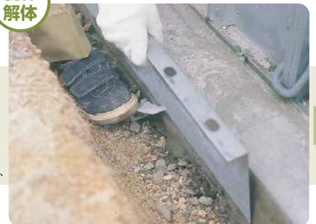
樹脂スペーサーはベース部に沿って左右に折り曲げます。(折れない場合には、押さえながら外します。)
