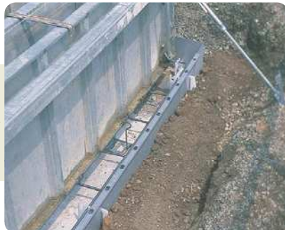
12. ベース部分に隙間がある場合には、多少埋戻しをします。
