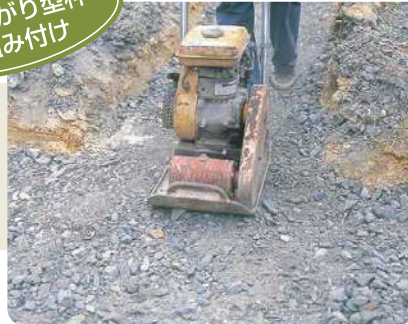
1. 碎石を転圧し、レベルを出します。(±10程度)
