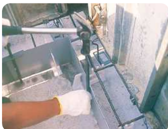
9. 内コーナー部の組み付け。鉄ベース枠300内コーナーと鉄ベース枠とを125mmほど重ね、樹脂スペーサーをセットし、重なった鉄ベース枠の穴に鉄ベース枠支持棒をクイ打ちします。
