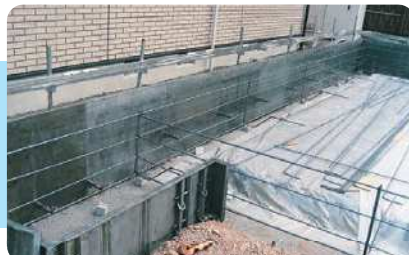
16. ハーフ吊中止金具を墨に合わせて、600mm以内に釘で固定します。次に、外周型枠を組み付けながらベタ中間セバを任意の高さに設置します。(コーナー部・500mm以内)(直線部1000mm以内)
