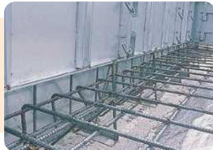
13. 直線部のパネルを段セバの上に順次組み付けていきます。
