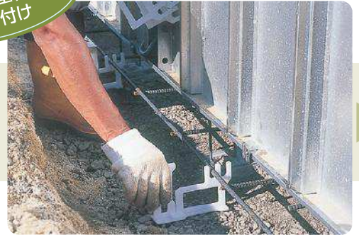
8. 外コーナー部の組み付け。鉄ベース枠は外コーナー部より組み付けます。樹脂スペーサーを約1m間隔でベース鉄筋に取り付けます。
