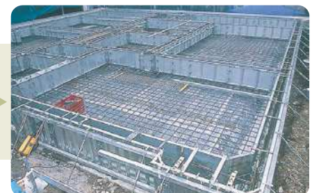
22. 外周型枠、土間セバレーターの組み付け完了です。
