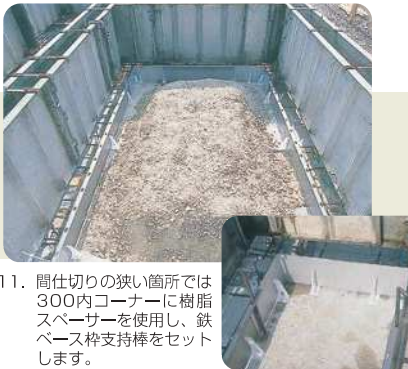
コーナー部より鉄ベース枠を樹脂スペーサーに差し込んでセットしていきます。これにより、ベース鉄筋のかぶり厚が確保できます。
