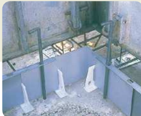
両サイド2箇所穴に鉄ベース枠支持棒を入れてください。
