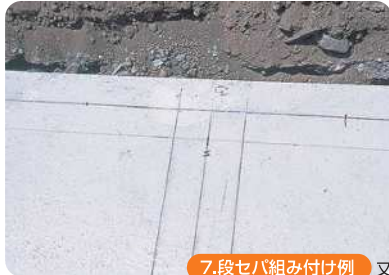
6. 芯墨を打ちます。→ 7.段セバ組み付け例 又は 16.中間セバ組み付け例
