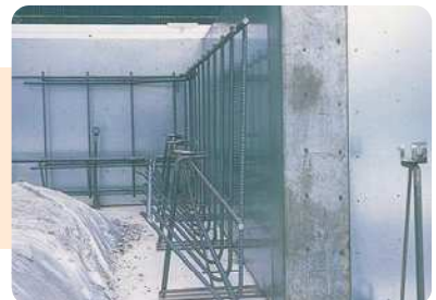
11. 立ち上がり筋とスラブ筋をセットします。
