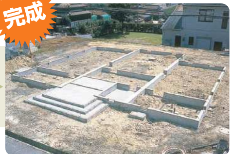
16. 鉄ベース枠と立ち上がり部を脱枠し整地を行えば、ベース立ち上がり一体打ち基礎の完成です。
