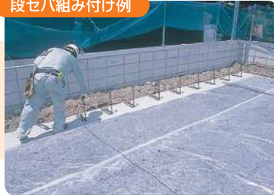
7. 段セバを墨に合わせ600mm以内の間隔で設置していきます。
