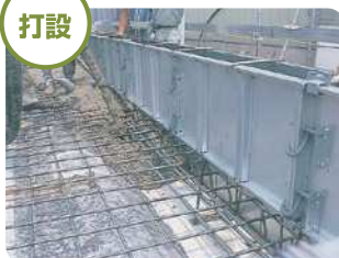
23. コンクリート打設は外周ベース部、間仕切り基礎ベース部より2回に分けておこないます。立ち上がり部打設後、最後に土間部を打ちます。
