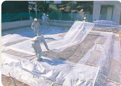
3. 防湿シートを敷きます。
