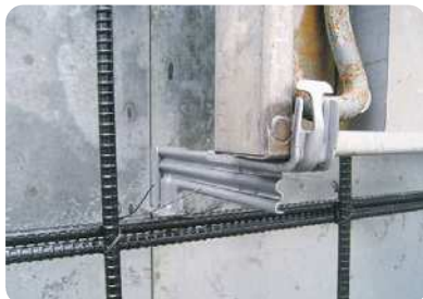
18. ベタ中間セバの爪をしっかり折り曲げます。
