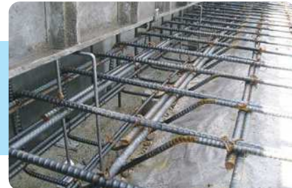
19. 外周内側型枠部にはシングル鉄筋ベースを入れます。
