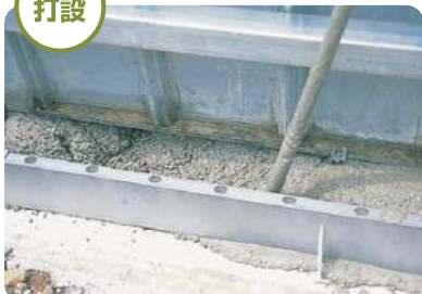
14. ベース部分のコンクリート打設と立ち上がり部のコンクリート打設は、多少、時間を置いて2周打ちします。1周目はベース+立ち上がり部の5cmまでとし、パイプレーターを使用するようにします。
