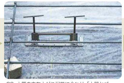
20. 土間の立ち上がり配筋に合わせ「土間セバスパーサー」を設置していきます。
