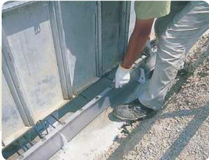
コーナー部より鉄ベース枠を樹脂スペーサーに差し込んでセットしていきます。これにより、ベース鉄筋のかぶり厚が確保できます。
