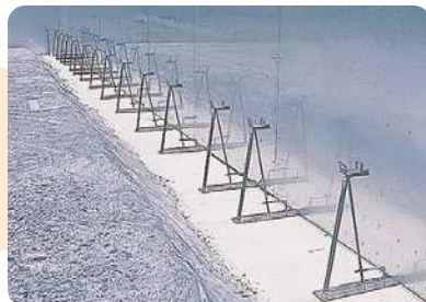
10. 直線部のパネルを順次組み付けていきます。
