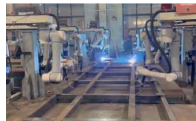
炭素鋼フレームの溶接
