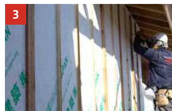
3 透湿防水シート張りと同縁の施工
