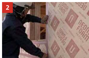
2 気密テープ張り
