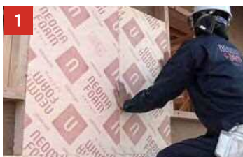
1 ネオマフォーム施工
