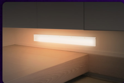
玄関 下駄箱下
