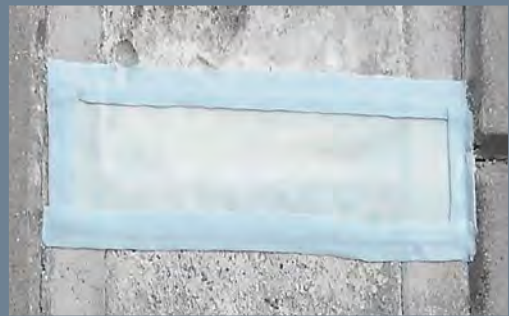
パッチシールクロス貼付後、 パッチテープで端部を処理した例。
