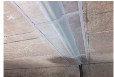
段差のある目地に施工した例
