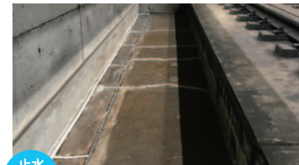
止水 Water stop コンクリートクラックの漏水補修 Repair of water leakage from concrete cracks
