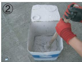
用意した水性塗料にペイントマスターを投入し、攪拌します。
