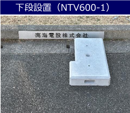
下段設置 (NTV600-1) 電源線の引込方向を決定してください (土間及び基礎の水平を確認)
