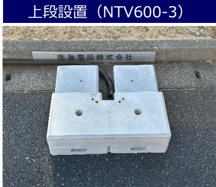
上段設置 (NTV600-3) 配管を立上げ、下段基礎インサートネジ 部と上段基礎貫通穴が合うように設置 してください
