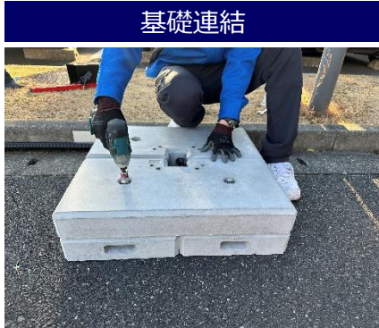
基礎連結 基礎設置後、貫通穴4ヶ所に付属のボ ルトを差込みレンチで締め付けて下さい
