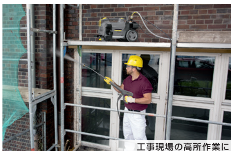
工事現場の高所作業に
