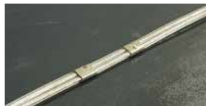
漏水システム復帰完了！
