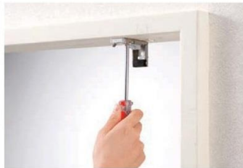
窓枠の正面もしくは壁面に取り付ける場合(正面付け) 窓枠の内側に取り付ける場合(天井付け)
