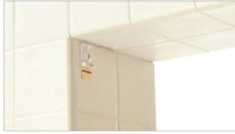
取付け位置を決めたら、プレート受けのツメ側が下になるように、両方の壁面に付属の両面テープを使ってプレート受けを貼り込んでください。
