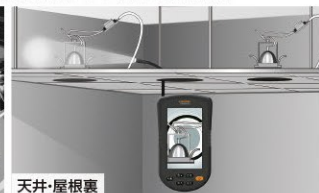
天井・屋根裏
