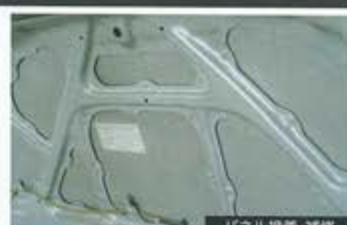
パネル接着・補修
