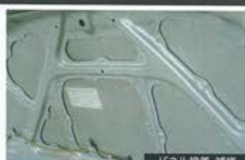
パネル接着・補修
