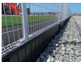
石川県内施設緑地 (ルートバリア 30S)
