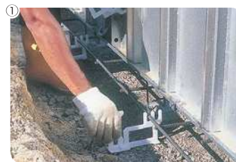
① 樹脂スペーサーを約1m間隔で両サイドのベース補助筋に取付けます。
