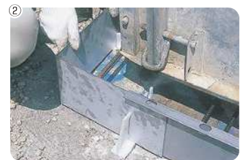
② 鉄ベース枠を樹脂スペーサーに差込みます。鉄ベース枠の継ぎ部(重ね部分)に樹脂スペーサーを取付けて下さい。鉄ベース枠が自立し、鉄筋の被り、通りが正確にできます。
