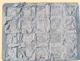
③養生します。
