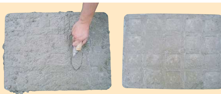
②生コンを入れコテで均します。
