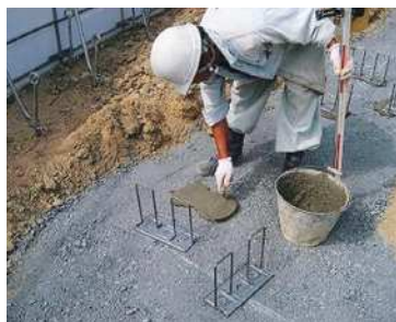
①モルタルをコテで均します。
