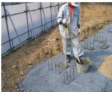
②レーザーレベルで高さを確認します。
