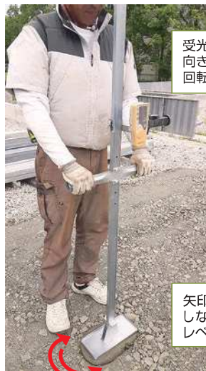
②レーザーレベルで高さを確認します。
