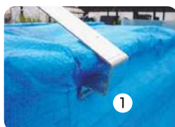
2. ①側から型枠天端に取り付ける
