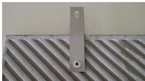
ステン板をタイル裏面に取り付け付けた様子
