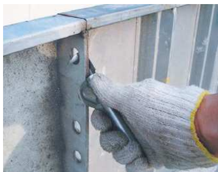
KRクリップでパネルの連結をし、固定します。【KRクリップP73】
