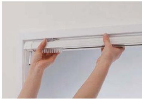
取付けたブラケットにヘッドレールをまず手前からはめ込み、さらに奥側をカチッと音がするまで押し込んでください。
