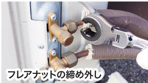
フレアナットの締め外し
