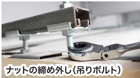
ナットの締め外し(吊りボルト)
