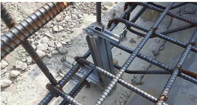
ハーフ吊巾止金具を設置して、段セパはフリーの状態にしておく
