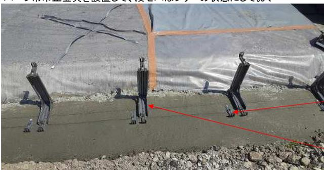
ハーフ吊巾止金具は600mmピッチ以内で釘固定する
