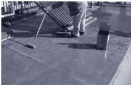
刷毛またはローラーを用いて、ベストシーラーK+Kパウダー20%混合品を塗り残しのないよう均一に塗布します。吸い込みの激しい場合は、再度塗布してください。降雨等により間隔が開いた場合は当社にお問合せください。
