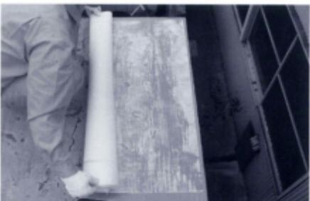
アトレース水性防水材を接着剤として塗布し、直ちに補強布を張り付けます。補強布張り付け直後に目止めとしてアトレース水性防水材をローラー刷毛にて塗布します。補強布に塗料を充分に染み込ませることが必要です。力を入れすぎると補強布がヨレるので注意してください。
