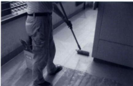
(平 場) ローラーを用いて、アトレース水性防水材を規定量、均一に塗布します。塗り回数は通常3回とし、塗り重ね時は、前回の塗り方向と直角になるように塗布してください。
