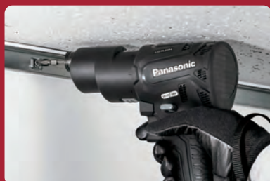
壁際のメタルモールの取り付け
