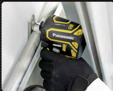
配管固定サドルの取り付け
