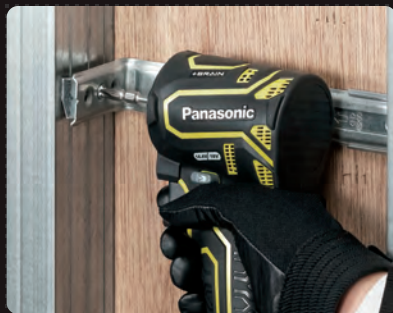
ボックス支持金具の取り付け
