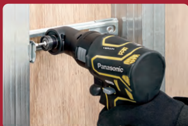
配線支持金具取り付け
