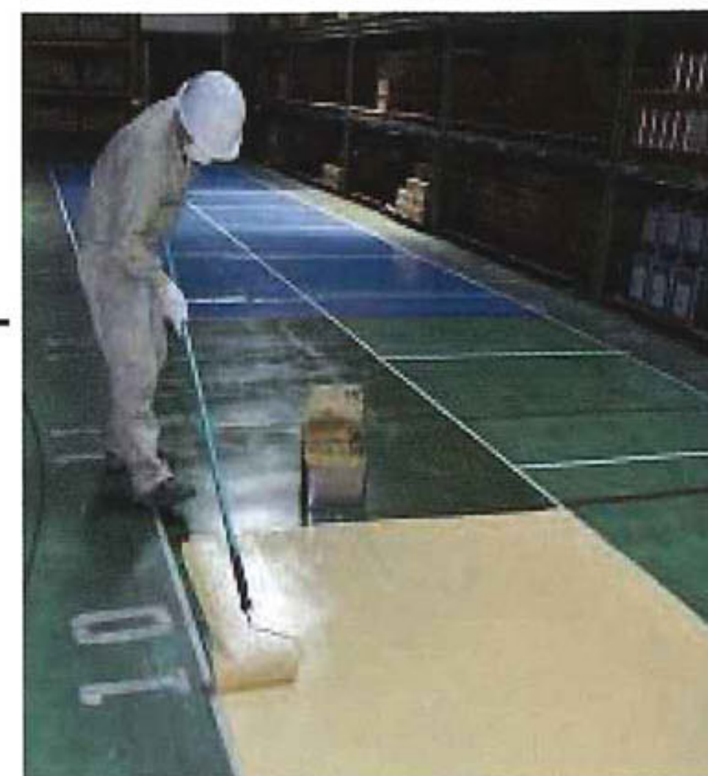
2. 撹拌した塗料は、ローラーで縦横に十字を切るように塗るとキレイに塗ることができます。
