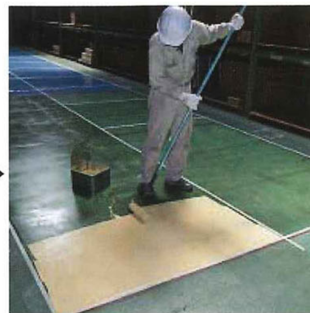
2. 撹拌した塗料は、ローラーで縦横に十字を切るように塗るとキレイに塗ることができます。
