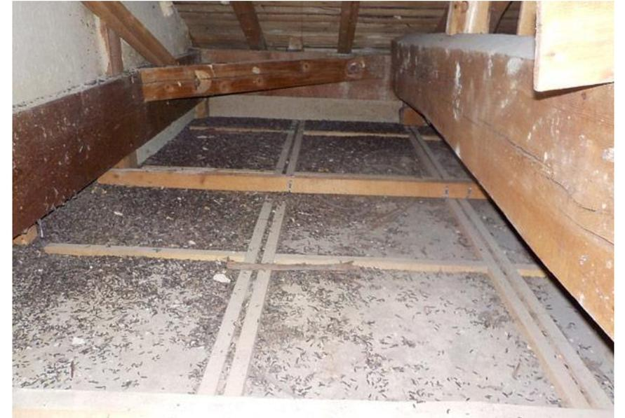
コウモリの侵入が確認された天井裏の例、コウモリの糞が散乱している
