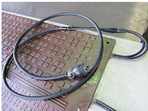
最上段の中タイプの上側の連結ケーブルと電源ケーブルを接続します。
