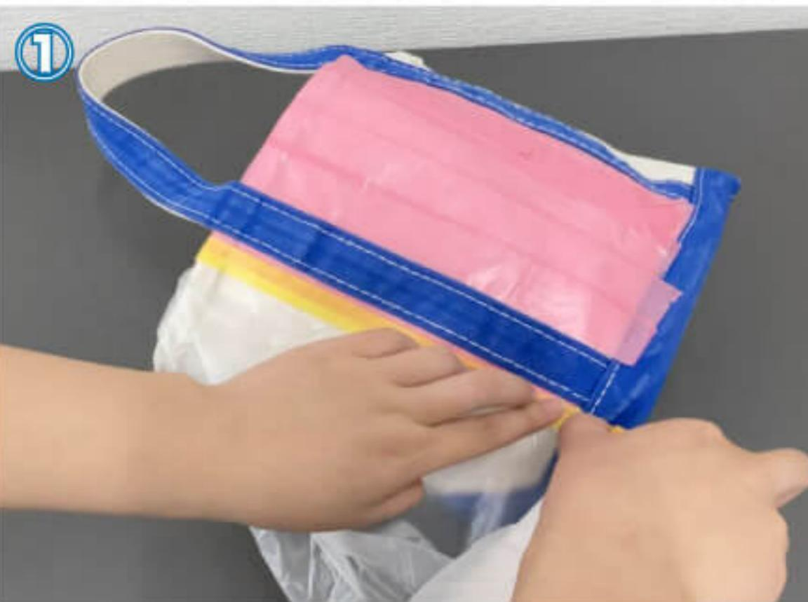
スプレーしたくない箇所を、新聞紙やマスカ―などで養生してください。スプレーの飛び散り防止に、周辺の壁や床面なども同様に養生してください。
