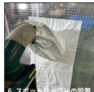
6. スポットクーラーの設置
