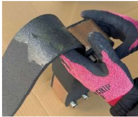
断熱材と BHE を貼り合わせる
