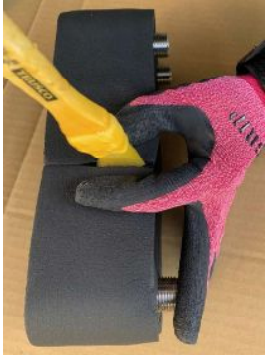
断熱材 C の端部間に 接着剤を塗布
