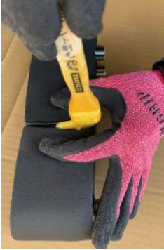
端部の上面にも 接着剤を塗布
