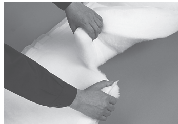
長さ調整は手でも可能です。 耳部分は、刃物でカットして下さい。
