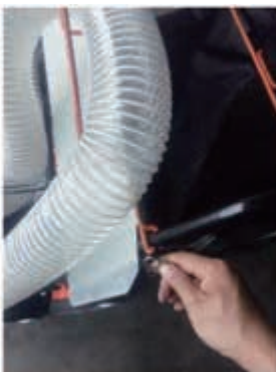
図 31-2 収集バッグ吊り下げ、プレートを取り外す
