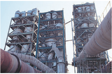
● セメント原料は乾燥、破碎、予熱され、長大なキルンの中を移動するうちに中間製品のクリンカに焼成され、粉碎工程を経てセメントとなります。
