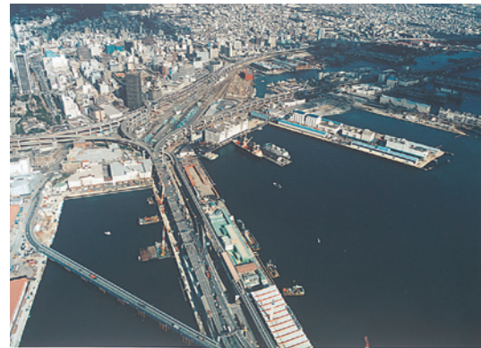
● 『神戸大橋』災害復旧工事（兵庫）
