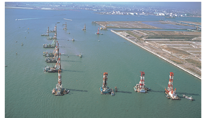
● 新海面処分場建設工事（東京）
