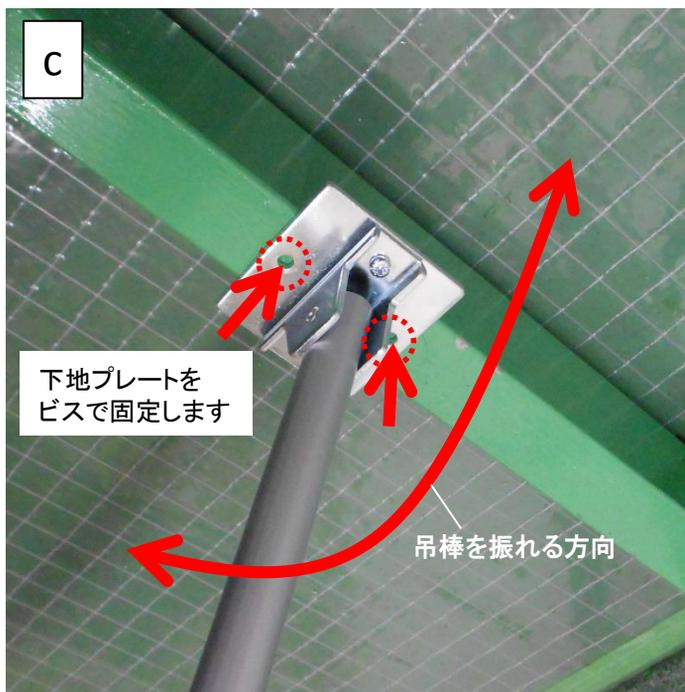
※下地プレートに伸縮吊棒を取付けるネジは、下地プレートに付属しております。
